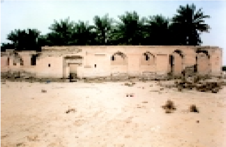
مسجد البطالية - المنطقة الشرقية
