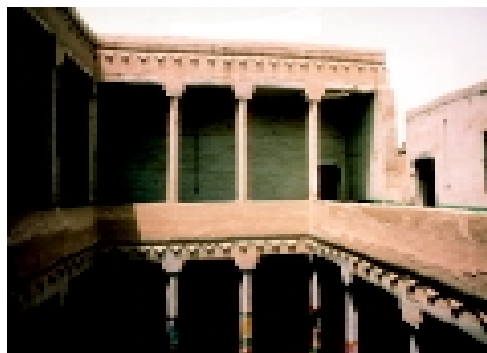
ممر محمول على أعمدة تطل عليه الغرفة الداخلية، مع طلاء الواجهات بالجبس الأبيض
