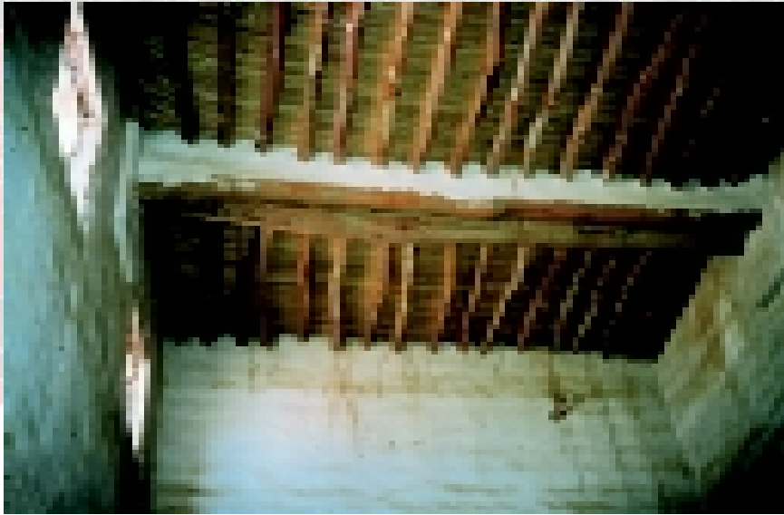
التسقيف بالسواكيف مع استخدام فرج للإضاءة والتهوية
