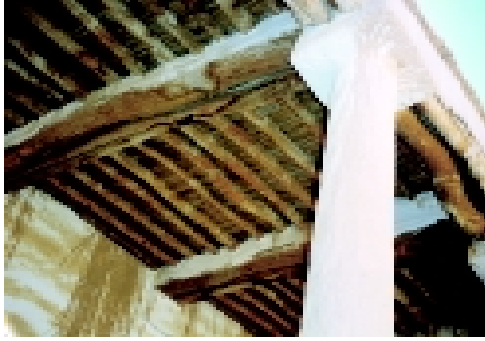
أستوانة فوقها تاج تدعم السقف المصنوع من الخشب والجريد
