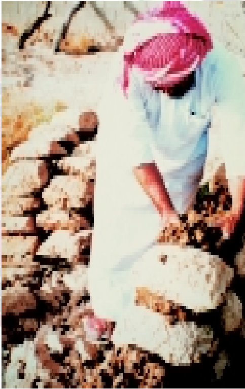
بناء الجدار باللبن
