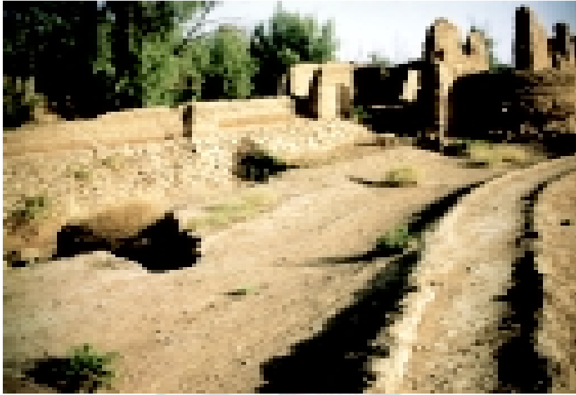
بئر قديمة ويظهر الساقى الرئيسي (القيوم) على يمين الصورة والمنحاة في عمق الصورة بمحاذاة الجدار الحجري
